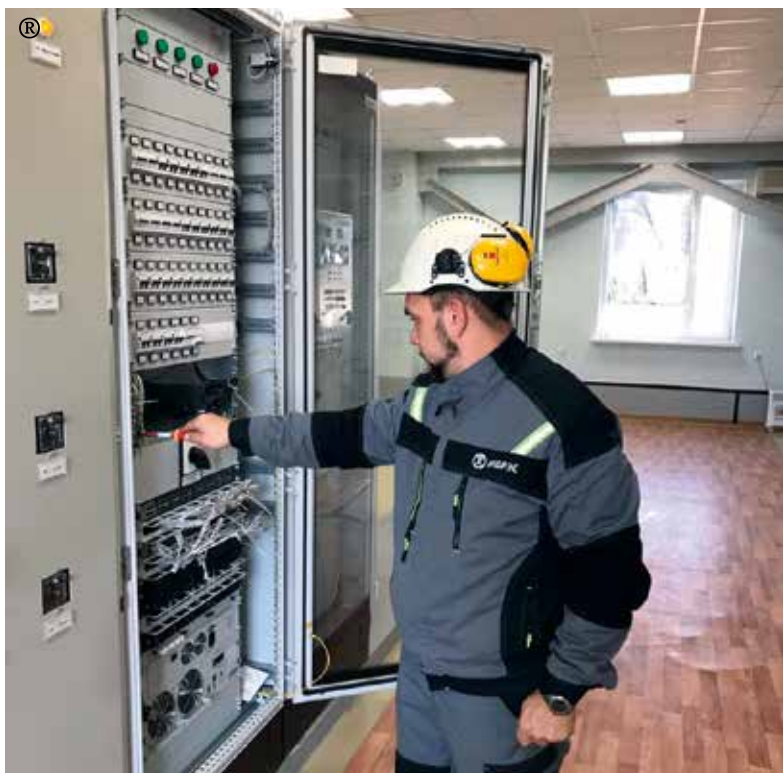
Наладка оборудования в рамках реализации проекта по модернизации систем сбора и передачи информации ПС 220 кВ «Сальская» филиала ПАО «ФСК ЕЭС» — МЭС Юга
